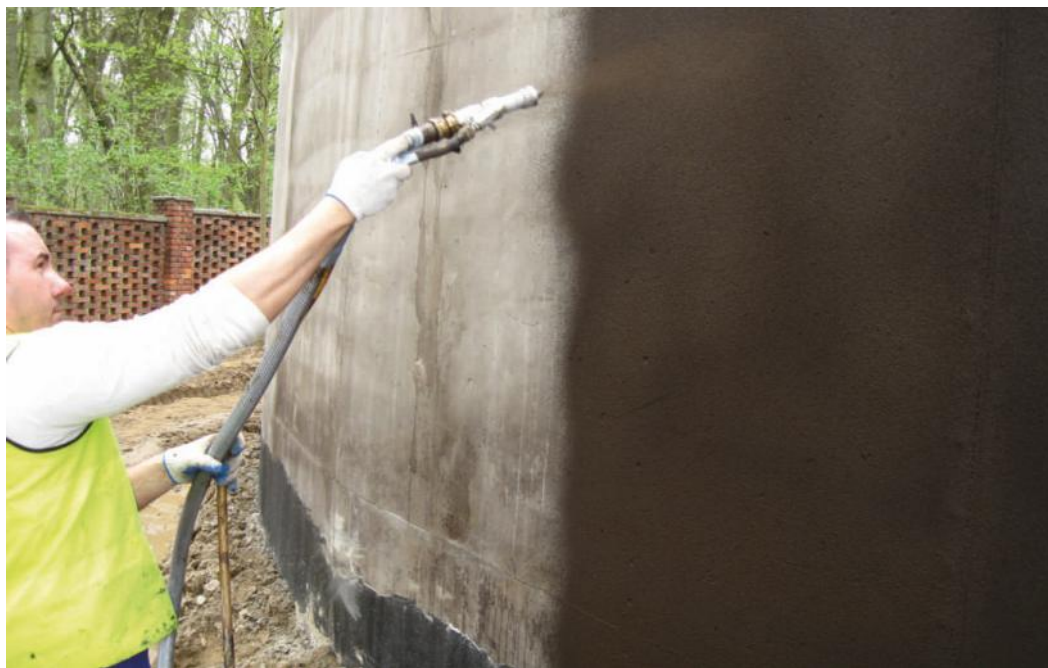
IZOLACJA BITUMICZNA APLIKOWANA METODĄ NATRYSKOWĄ
