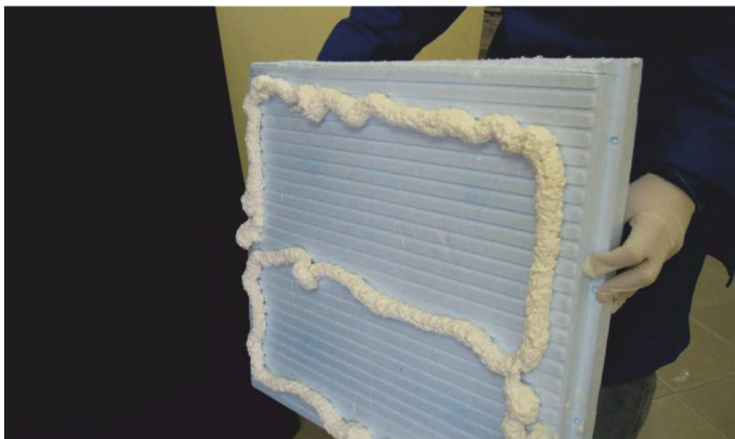
KLEJENIE PŁYT XPS NA PIANKĘ POLIURETANOWĄ
